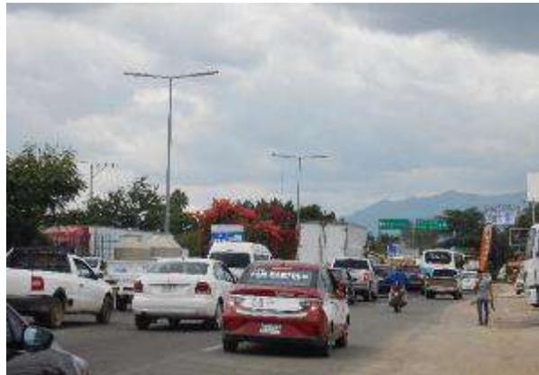
Las condiciones de la carretera son irregulares, principalmente en el eje que está indicado por el camellón central, teniendo variaciones en los anchos de los carriles mismos que provocan inseguridad al conductor, generando así disminución de velocidades reflejado en mayor tiempo de traslado y altos costos de generales de viaje (CGV).
