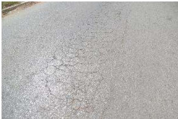
**Fotografía 19. Bache profundo con daño en la base hidráulica, km 5+580 hacia el Aeropuerto.** Municipio: San Agustín de las Juntas, Localidad: San Agustín de las Juntas, Geoposición: Latitud 17.005937° Longitud: -96.712967°
